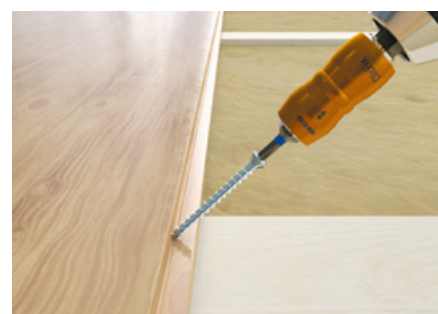
Vastzetten van vloerplanken
