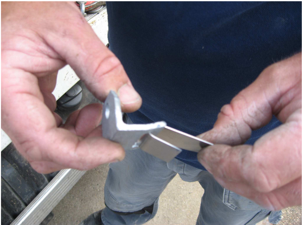
Stap 3 Zaag of knip de trekband af op de afgetekende lengte
